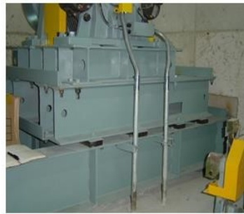
Dây điện của động cơ
